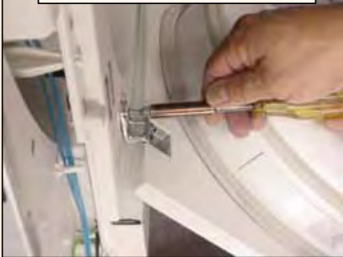
Removing door hinges
